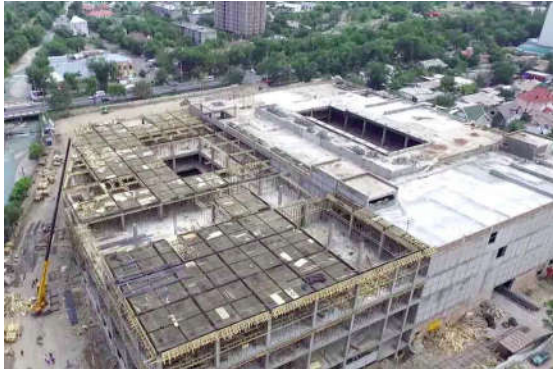
Một góc công trường thi công cải tạo liên hợp xây dựng nhà ở cũ thành các tổ hợp nhà ở và công trình công cộng
